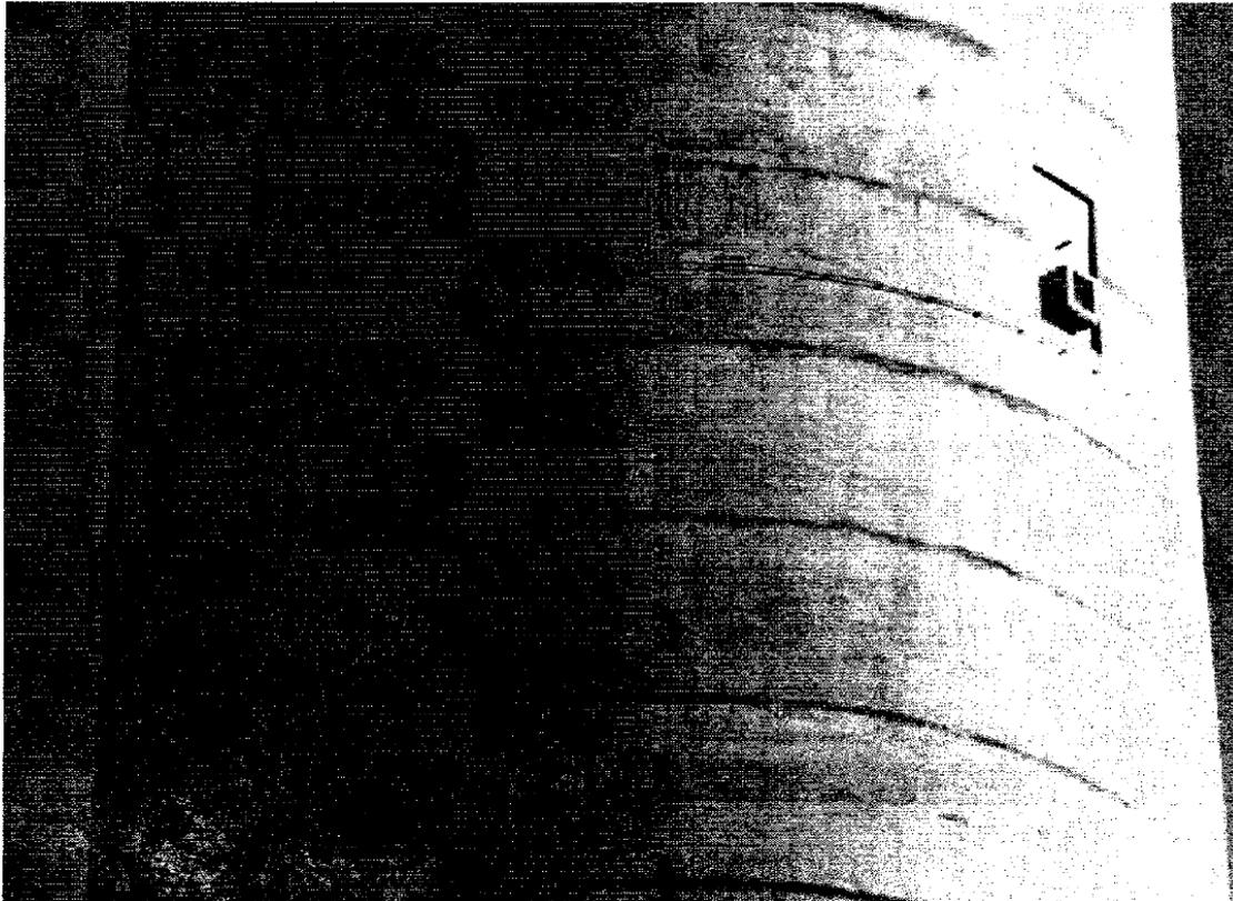
Figura 14-2. Luces de obstáculo de elevada intensidad instaladas sobre una chimenea
