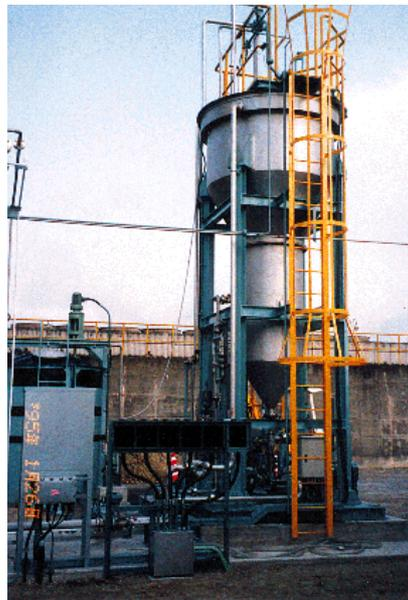
Figura 6. Planta para la recuperación de estruvita de aguas industriales en Ube Industries Sakai, Japón. Construida por Unitika Ltd, Osaka ( $48 \text{ m}^3/\text{d}$ ). En operación desde 1995.
