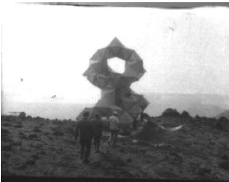
**Figura 3** Instalación de captanieblas poliédrico en Morro Moreno (1979) a 900 metros sobre el nivel del mar (foto gentileza Dr. Orlayer Alcayaga, U. del Norte)
