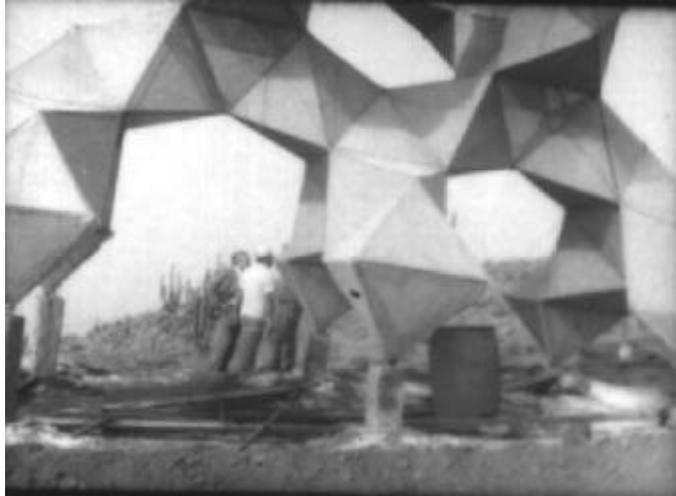
**Figura 4** Base de captanieblas de Morro Moreno. Se observan vértices de captación de agua (foto gentileza Dr. Orlayer Alcayaga, U. del Norte)
