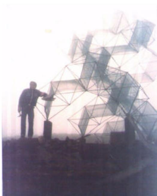
**Figura 5** Captanieblas poliédrico en "Los Nidos". En la foto se ve el captanieblas en operación (1990, foto gentileza Dr. Orlayer Alcayaga, U. del Norte)
