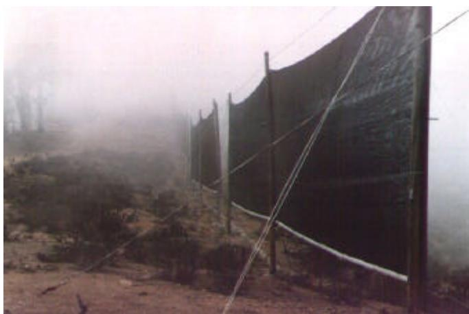
**Figura 7** Captanieblas de 90 m<sup>2</sup> en Cuesta El Tofo. Se distinguen las canaletas para recolectar el agua (foto del autor, 1996).
