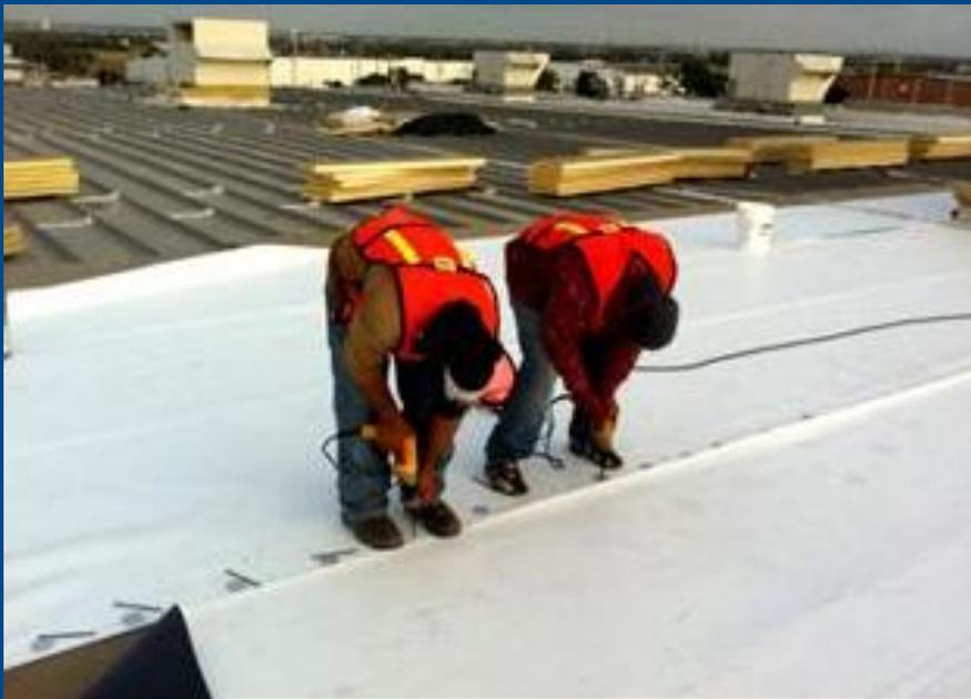
Finalmente se realiza la instalación del sistema de impermeabilización sobre el aislamiento. Los traslapes de todos los rollos deben ser termofucionados, así como se deben sellar todos los detalles que tenga la cubierta como equipos de aire acondicionado, chimeneas, antenas, orillas de techo, etc. Todos los traslapes y detalles deben ser sellados correctamente para buen desempeño de la membrana, evitando la filtración de agua, polvo o viento.
