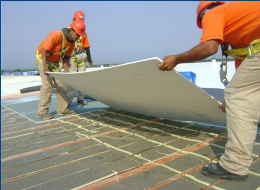
▶ Colocación de capa niveladora de aislamiento (adherida o mecánicamente fijada)
