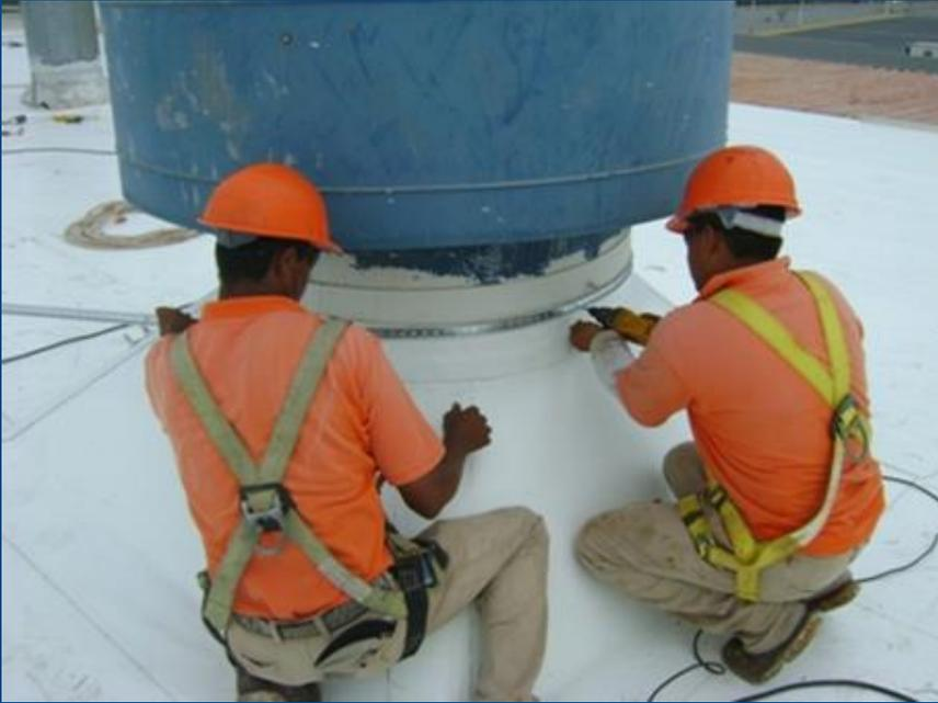
▶ Sellado de detalles típicos: equipos, penetraciones, bajadas pluviales, pretilas, juntas de expansión, etc.
