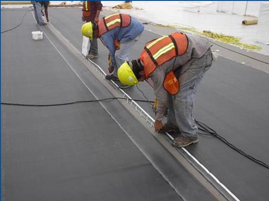
▶ Extensión de membrana y fijación con barra de sujeción
