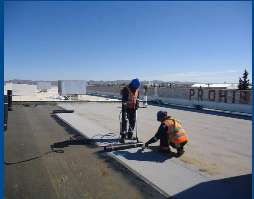
Sellado de detalles típicos: equipos, penetraciones, bajadas pluviales, pretilas, juntas de expansión, etc.
