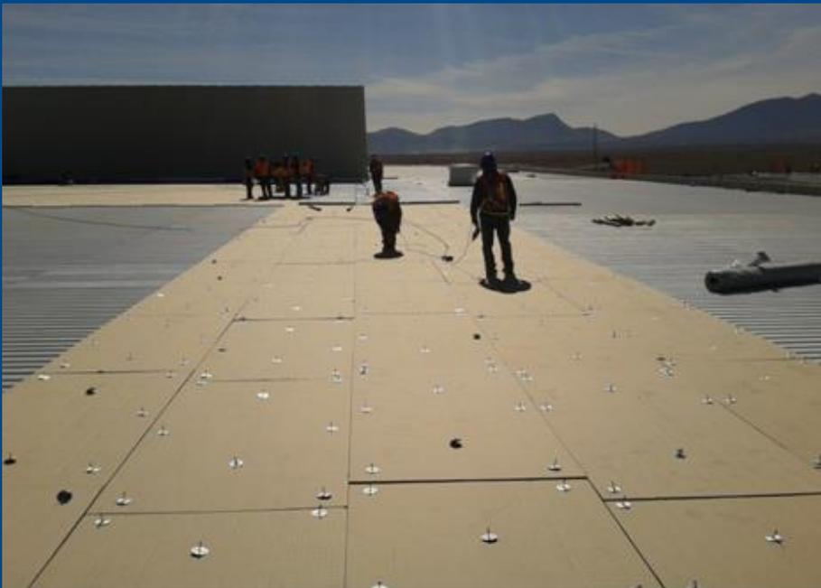
► Fijación mecánica de aislamiento en lamina o losa.
