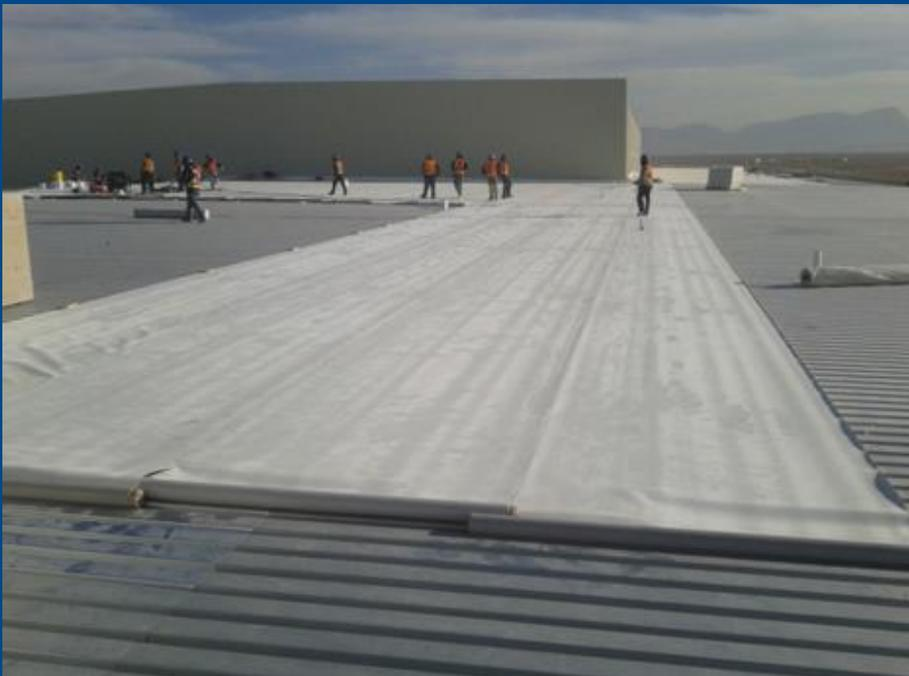
► Colocación de membrana impermeabilizante sobre aislamiento.
