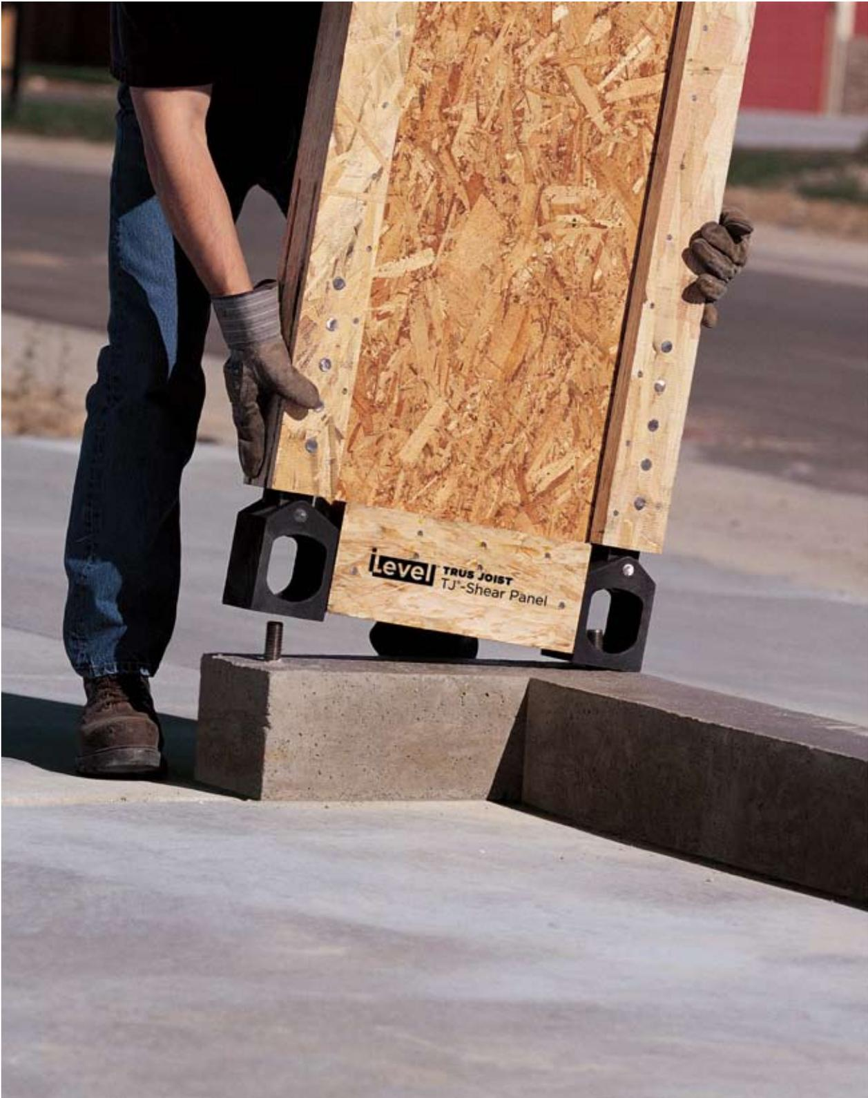
Pilar compuesto con alma de tablero OSB
