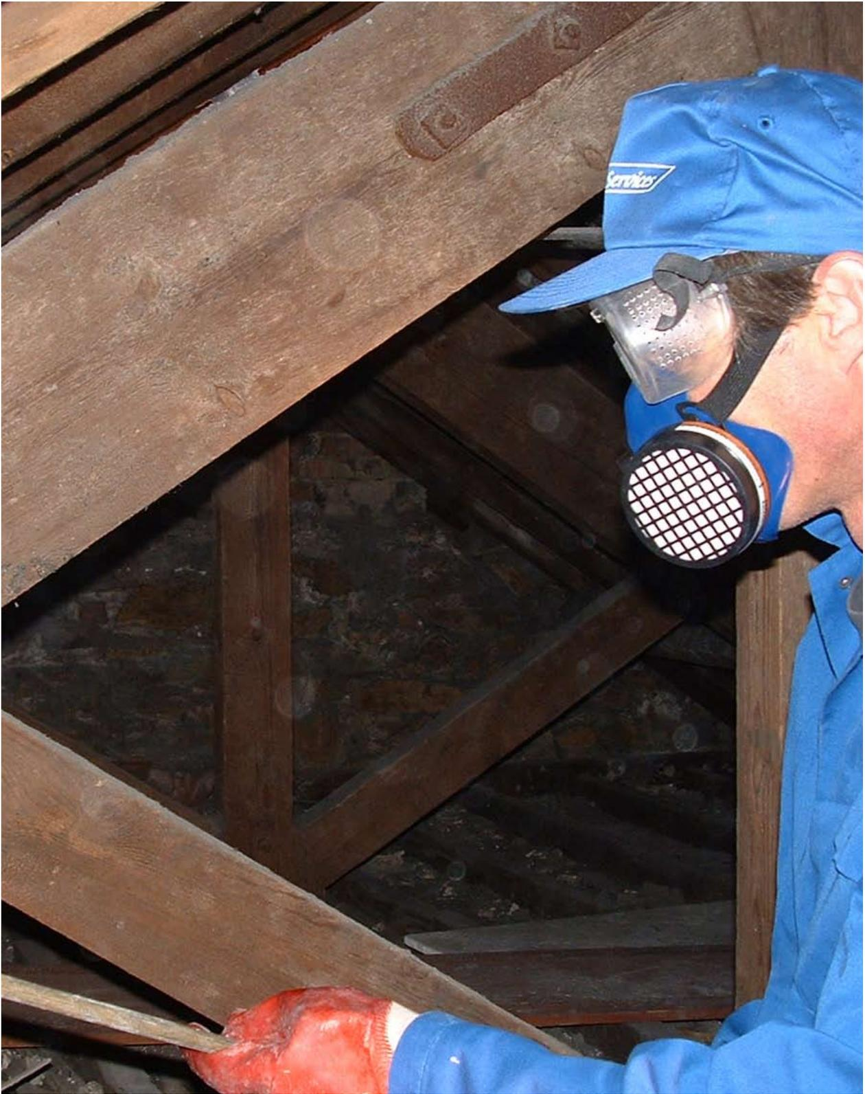
Se realizan mediante el empleo de un equipo que inyecta a presión el producto protector a través de boquillas unidireccionales (sin retorno). Este tipo de tratamiento se realiza generalmente con protectores de tipo orgánico. También se pueden efectuar tratamientos de inyección sobre muros, tabiques y suelos, que son especialmente útiles en tratamientos contra los hongos y las termitas.
