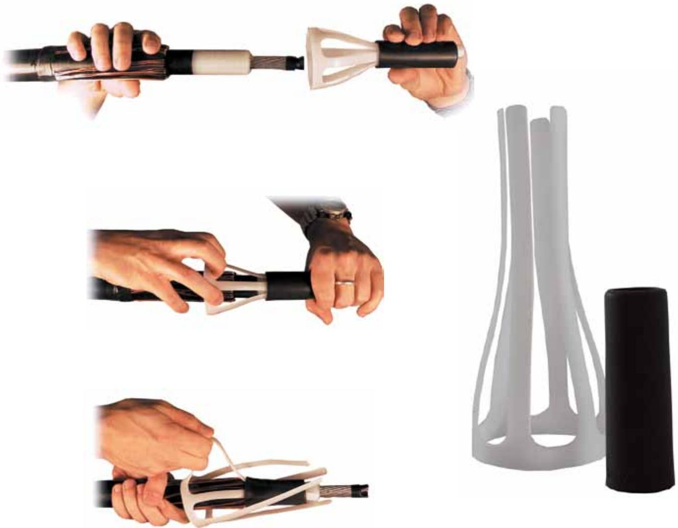
Fig. 3: Instalación de elemento de control de campo FSE con aplicador AH
