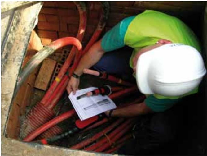
Gracias al concepto innovador de integración se logra que los componentes más críticos del empalme, los cuales en el pasado debían ser ejecutados por el instalador en obra, sean ahora preensamblados en fábrica en condiciones controladas y bajo estrictos controles de calidad. De esta manera el instalador sólo debe realizar unos pocos pasos fáciles de instalación en obra.
