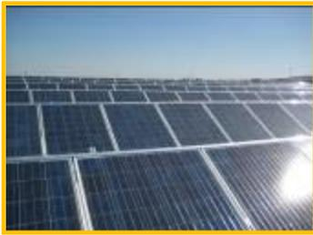
Asimismo, en febrero de 2010 HAVI inauguró una instalación de paneles de **energía solar fotovoltaica que ocupan 1.800 m<sup>2</sup>** de la cubierta de su Centro de Distribución de Osuna (Sevilla), que generan 230.000 Kwh anuales, un **30% del consumo de energía del centro de distribución.**
